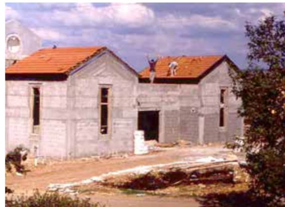
Bau des HOPS
