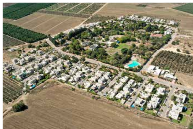
Bauarbeiten und Schritte der Dorferweiterung
